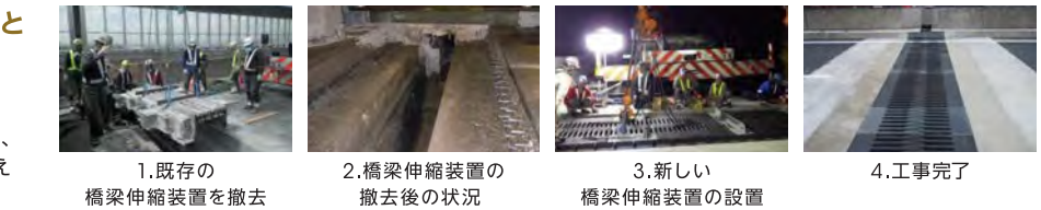
1.既存の橋梁伸縮装置を撤去 2.橋梁伸縮装置の撤去後の状況 3.新しい橋梁伸縮装置の設置 4.工事完了
