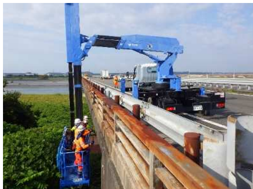
橋梁点検状況
