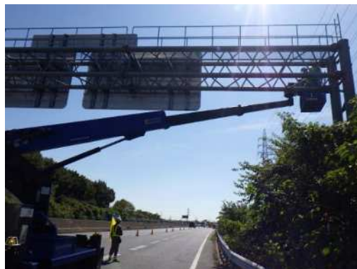
標識点検状況
