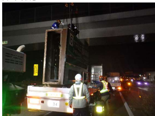
老朽化した情報板の撤去状況
