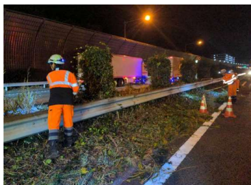
道路維持作業状況
